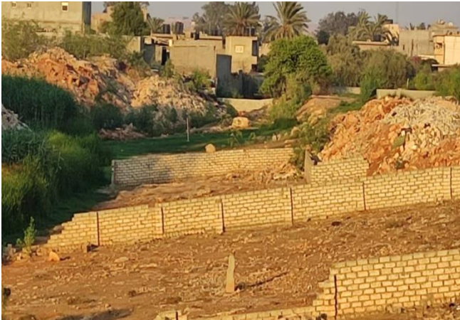
الصورة (3) البناء العشوائي في مجرى وادي القطارة بنينا
