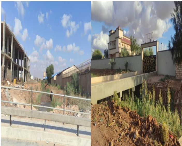
الصورة (4) البناء العشوائي على مجرى وادي القطارة في مدينة بنغازي
